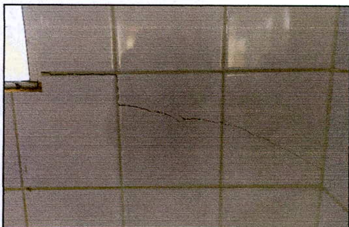
FIGURA 03 - Revestimento cerâmico danificado
